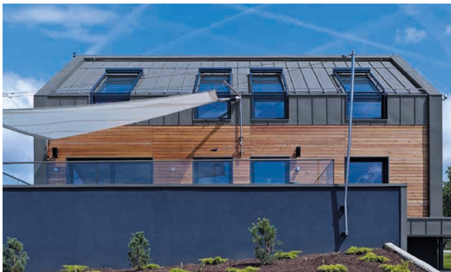
Junta de dobra cobrindo com espigão/fachada e cumeeira ventilada
