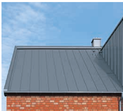
Junta de dobra cobrindo com espigão estreito a duas águas e cumeeira ventilada
