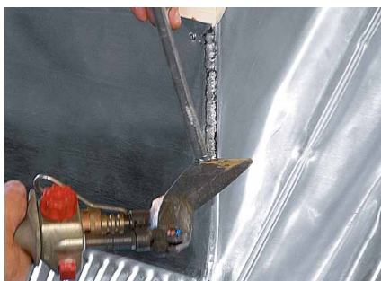
Soudure côté égout
