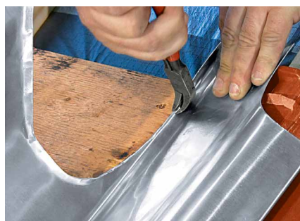
Préparation du joint de la pièce latérale
