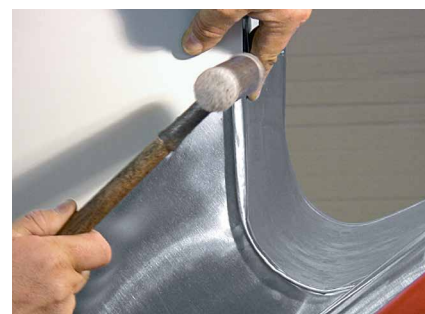
Réalisation du joint
