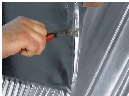
Réalisation du joint simple
