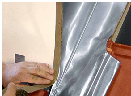
Pose de la bande adhésive
