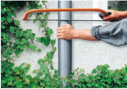
Découpe d'un morceau de tuyau de 30 cm environ
