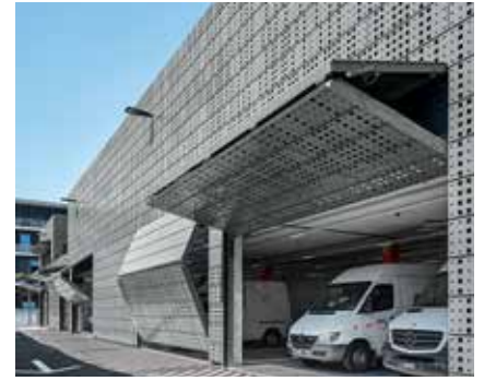
Sous-station de transformation Oerlikon, Zurich, Suisse
