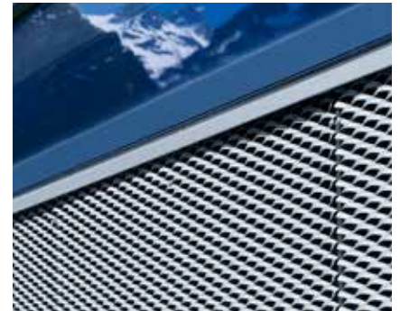
Caserne de sapeurs-pompiers, Bludenz, Autriche
