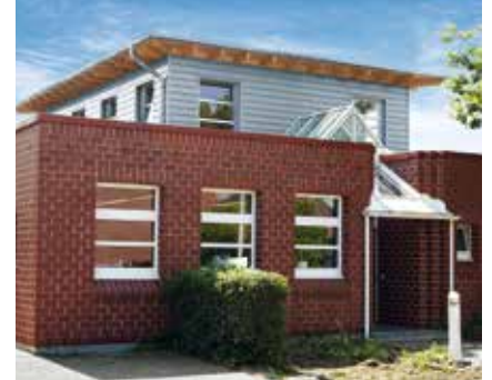
Caserne de pompiers, Dülmen, Allemagne
