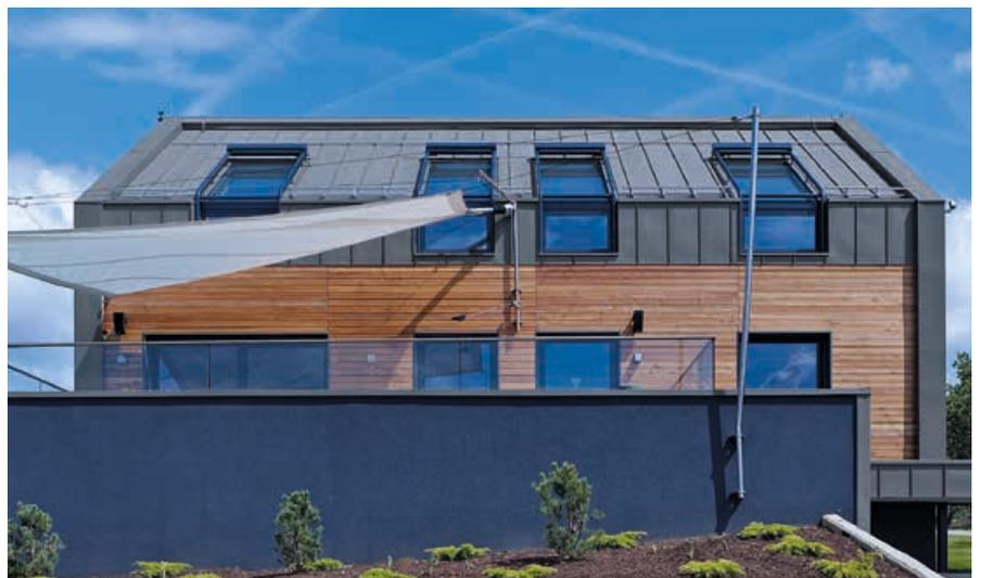
Junta de plegado cubriendo con faldón a cubierta/fachada y cumbre ventilada.
