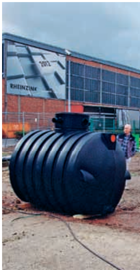
Einbau des nautilus-Regenwassertanks (4 m 3 )
