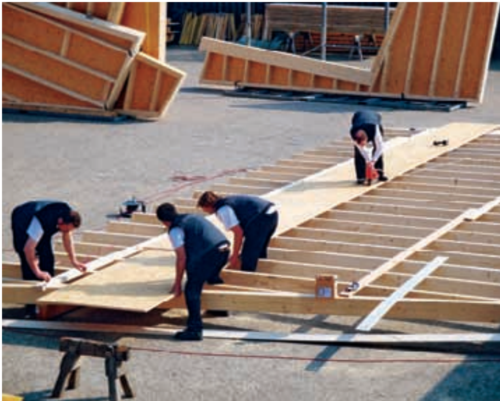
Holzrahmenbaukonstruktion – Vorfertigung und Montage
