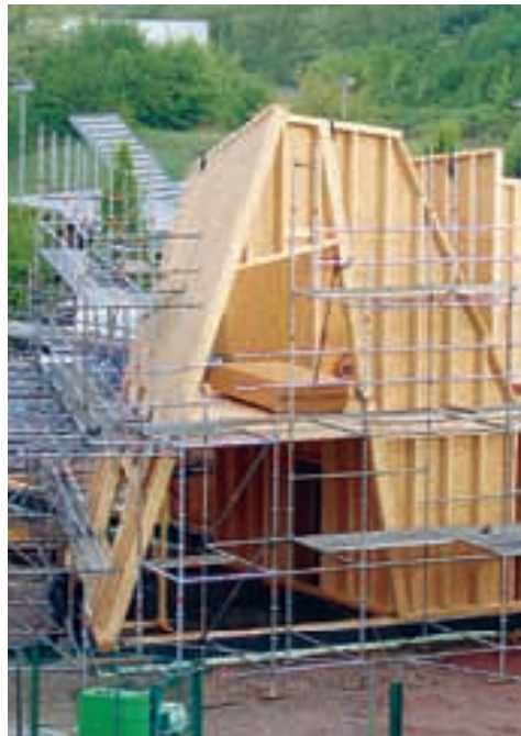
Eine Holzrahmenkonstruktion sorgt für hohe Maßhaltigkeit und eine kurze Bauzeit
