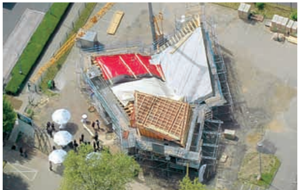
Richtfest nach nur 8 Wochen Bauzeit
