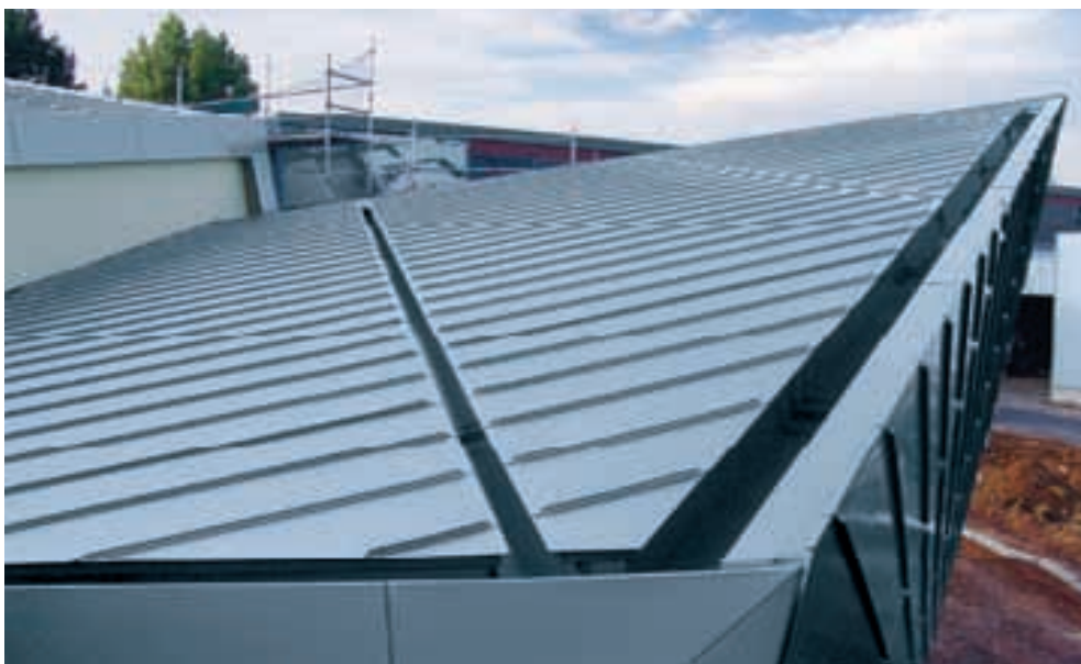
Dachaufteilung mit integrierter Dachentwässerung
