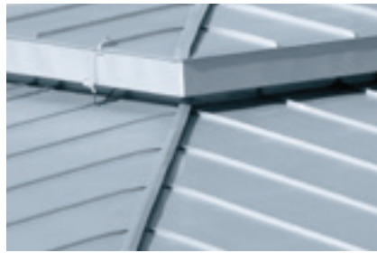
Nároží bez lišty, s krycím profilem
