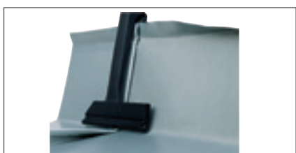
Zhotovení pomocí krycích kleští se zaoblenou hranou
