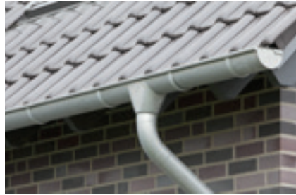
Montáž dilatačních prvků
