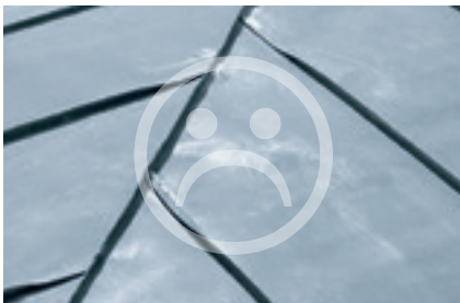
Nároží nebo hřeben jako dvojitá stojatá drážka
