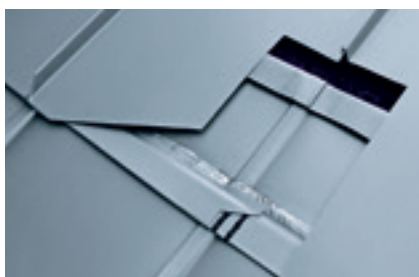
Optimalizace detailu: připevňovací pás přidavné drážky
