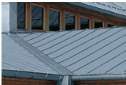
Úžlabí s jednoduchou ležatou drážkou a s přídatnou drážkou
