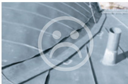
Úžlabí na dvojistou stojatou drážku (nafalcované úžlabí)
