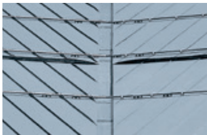
Zapuštěné úžlabí s podloženou strukturální rohoží
