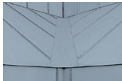
Úžlabí s jednoduchou ležatou drážkou
